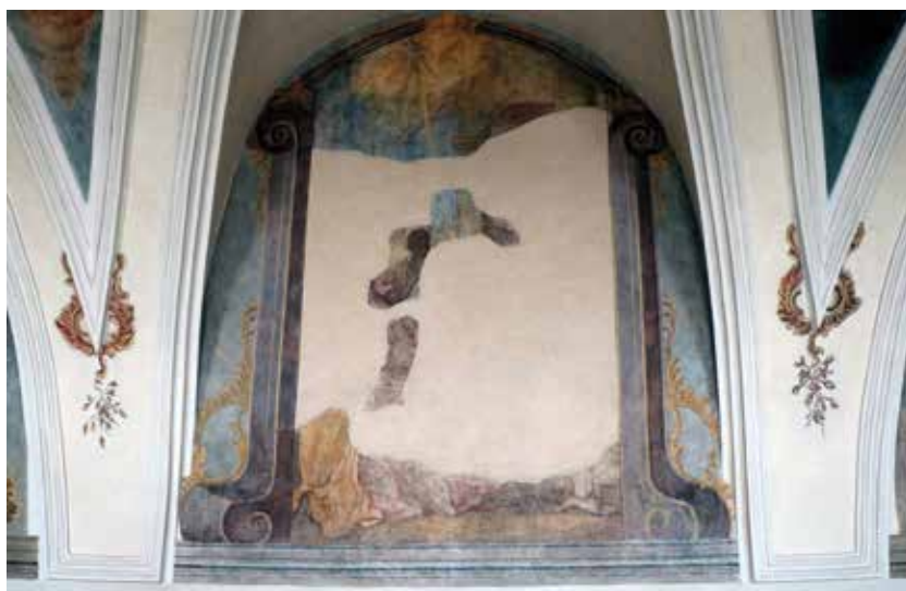
Osadzenie transferów w pierwotnej lokalizacji wraz z częściową rekonstrukcją brakujących fragmentów kompozycji. Fot. E. Grzywacz
