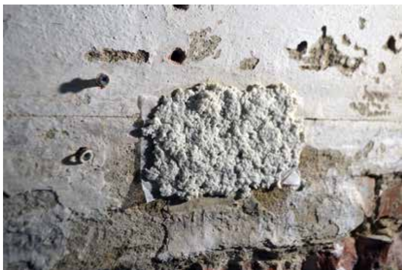
Ściana wschodnia. Próby konsolidacji rozwarstwionych pobiał wapiennych preparatami na bazie nanowapna.
