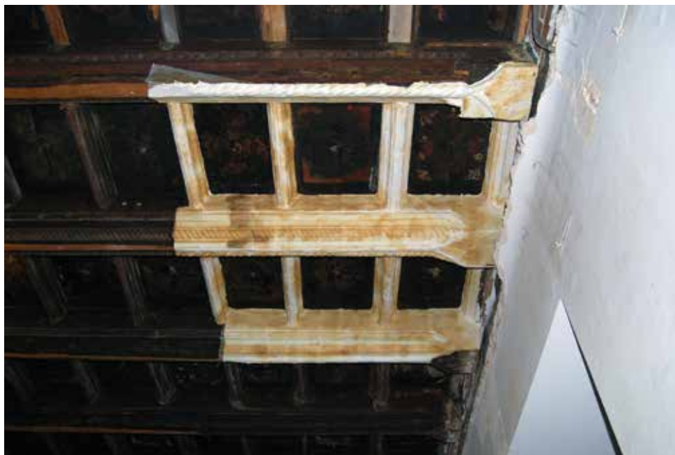
Oczyszczanie powierzchni wyznaczonego obszaru stropu przy użyciu wilgotnych kompresów. Fot. J. Wójcik Cleaning the surface of the chosen area of the ceiling using moist compresses. Photo J. Wójcik
