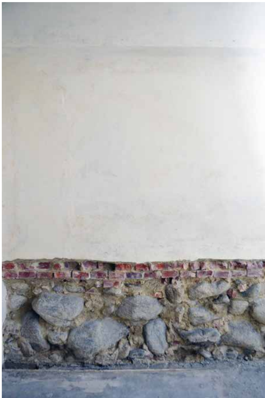
Zakopane, budynek hotelu „Palace”, dawna cela więzienna nr 3, ściana wschodnia. Stan po konserwacji. Fot. M. Tópolska
