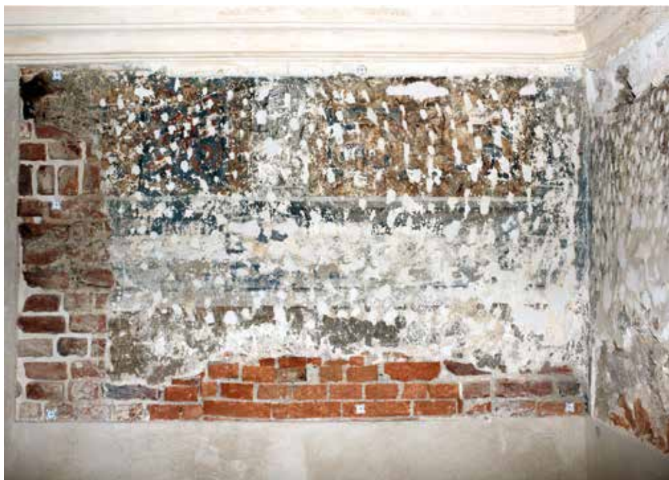
Kraków, Pałac Spiski, pomieszczenie 2.28, wschodnia ściana, fryz podstropowy z dwiema dekoracjami malarskimi. Fot. P. Gąsior
