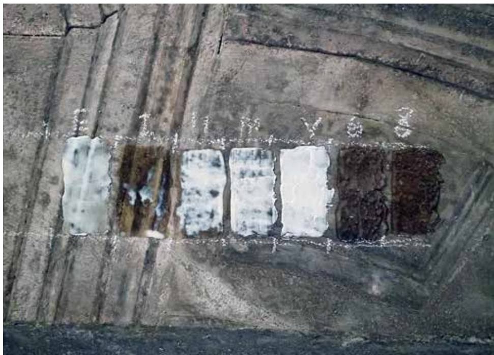
Ukraina, Lwów, kościół pw. św. św. Piotra i Pawła, ul. Teatralna 11, nawa główna, sklepienie. Widok malowidła podczas wykonywania prób; preparaty nałożone wg kolejności: A. M. ECO, A. M. I, A. M. II, A. M. III, A. M. V, agar pH 6, agar pH 8,5. Fot. E. Szarlata
