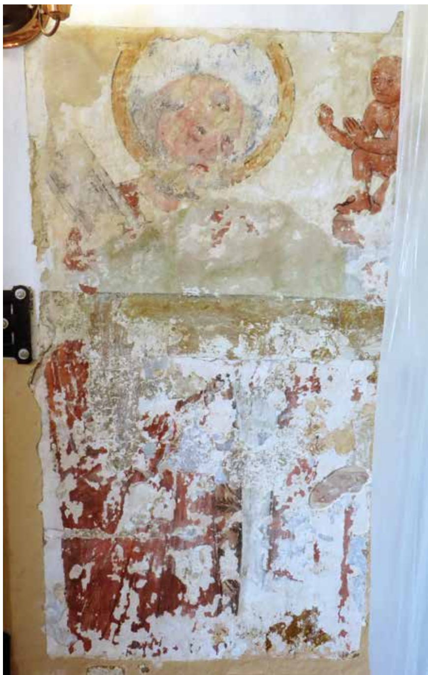
Stan w trakcie konserwacji, podczas odsłaniania gotyckiej polichromii. Fot. M. Skóra
