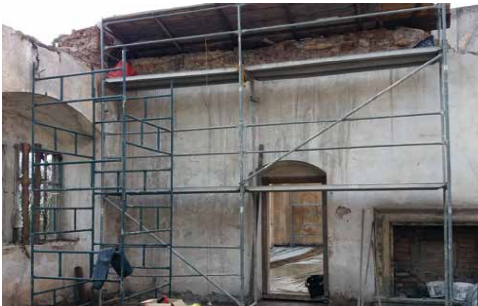
Zamek Sarny, trzecia kondygnacja, pomieszczenie środkowe w trakcie wschodnim (sala nr 2). Widok na ścianę południową w trakcie zdejmowania malowanego fryzu. Fot. I. Widlińska
