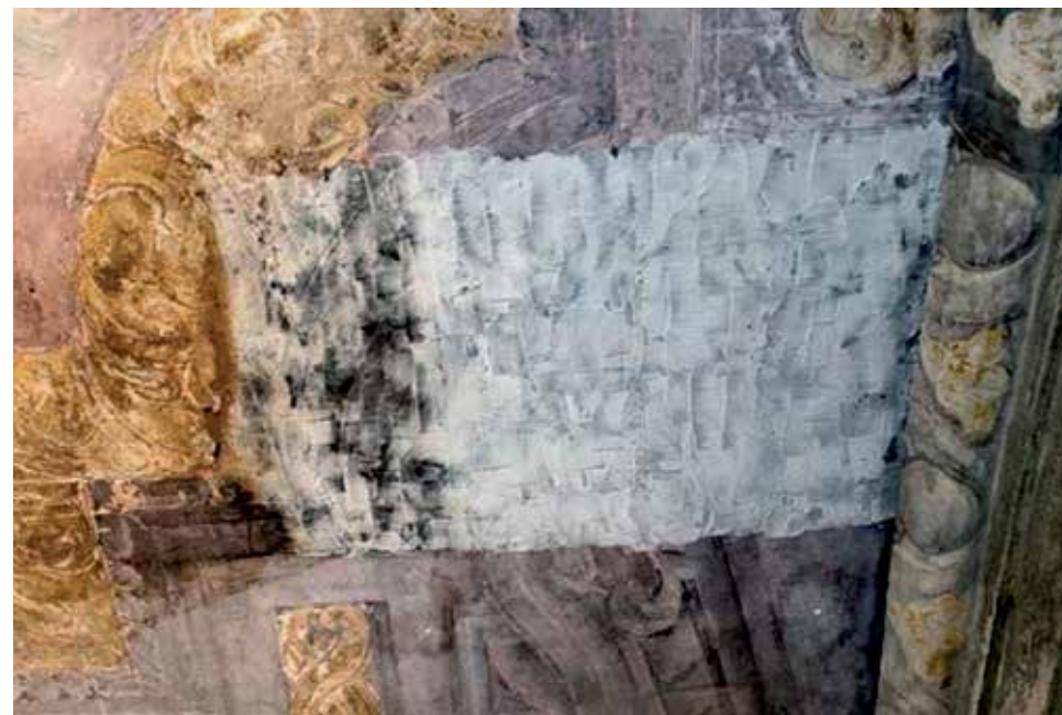
Ściana północna sklepienia nad prezbiterium przy gurcie. Fragment iluzjonistycznej architektury oczyszczony kompresami z roztworu węglanu amonu. Fot. K. Matusiak
