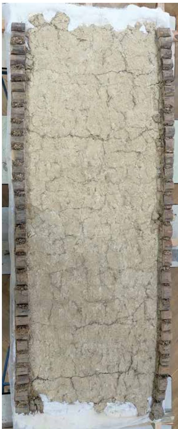
Odwrocie płata po usunięciu części oryginalnej konstrukcji. Fot. M. Kulaga
