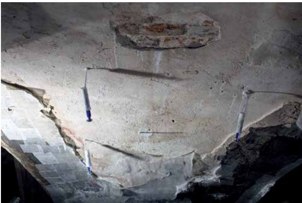
Ściana północna, w trakcie konsolidacji tynku zastrzykami z Ledanu TB1. Fot. K. Matusiak
