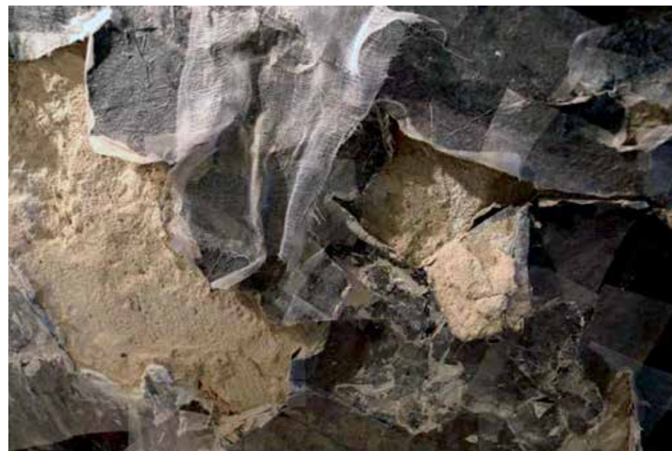
Ściana północna, fragment w trakcie konsolidacji rozwarstwowanego tynku i warstwy malarskiej oraz wykonywania minitransferów. Fot. K. Matusiak
