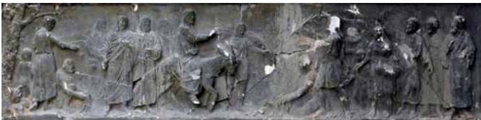
Gipsowy, patynowany fryz przed konserwacją. Widoczne silne zanieczyszczenia, spękania, ubytki formy rzeźbiarskiej i patyny oraz zachłapania zaprawą cementową. Fot. P. Krupa
