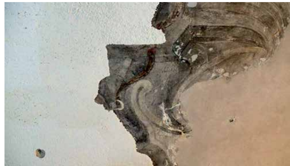
Kompres odsalający z włókien celulozowych Arbocel oraz wody, nałożony po oczyszczeniu preparatem lateksowym Arte Mundit. Fot. P. Boliński
