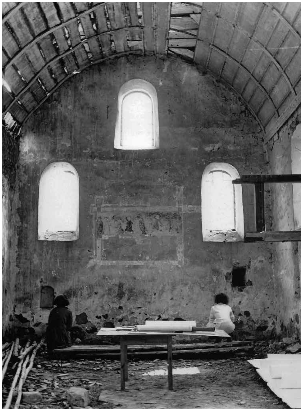
Wnętrze kościoła w Starkowie, ściana wschodnia – fragment odsłoniętego malowidła Sąd Ostateczny , 26 IV 1966. Fot. Z. Bradke
