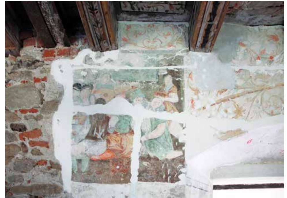
Dekoracja z końca XVI wieku po uzupełnieniu ubytków zaprawy oraz pobiałą. Fot. J. Wójcik
