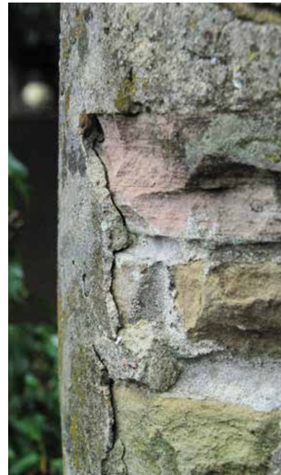
Fragment nagrobka rodziny Dutkiewiczów na cmentarzu komunalnym w Tarnowie. Widoczne patyna wykruszenia, ubytki, dezintegracja strukturalna kamienia, nawarstwienia mikrobiologiczne. Kwiecień 2015 r.
