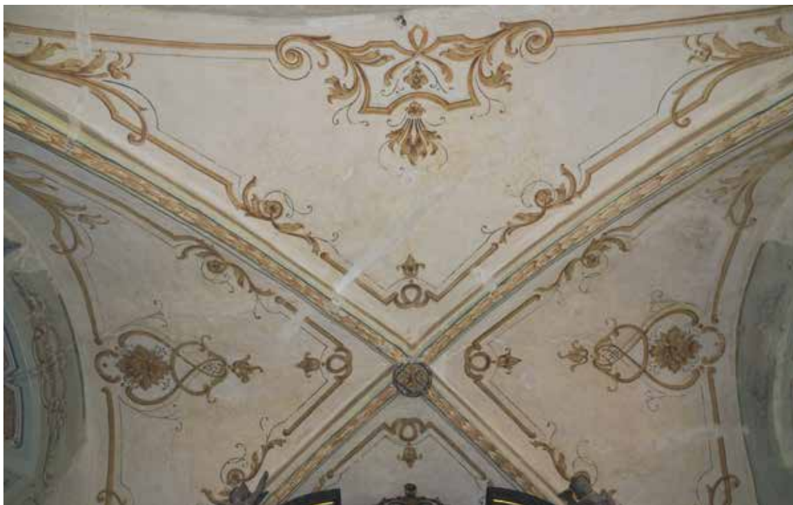
FOT. 7 Prezbiterium, sklepienie.
