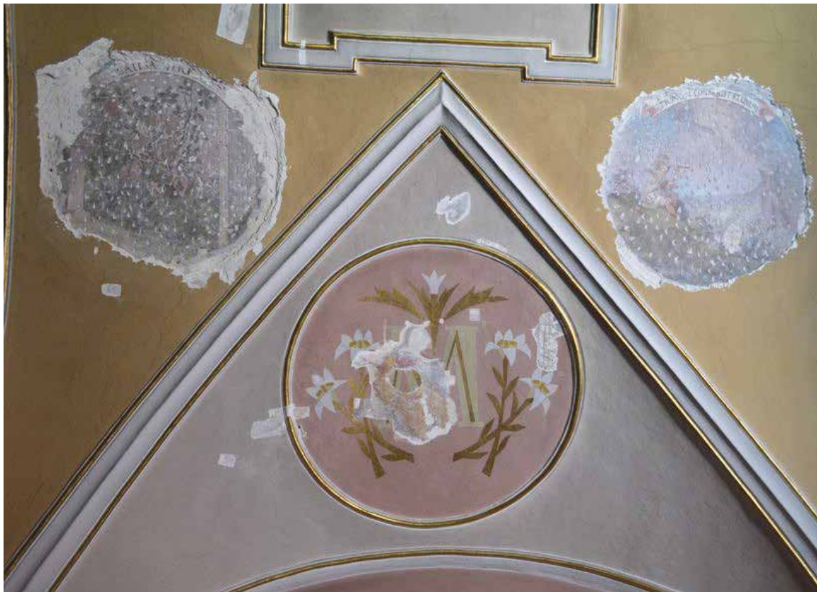
Kaplica pw. św. Barbary, widoczne odkrywki fresku z 1700 r. oraz sondy stratygraficzne, sklepienie.
