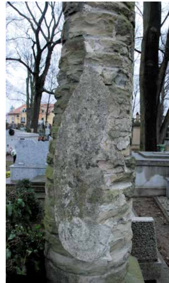
Fragment nagrobka rodziny Dutkiewiczów na cmentarzu komunalnym w Tarnowie. Widoczne patyna wykruszenia, ubytki, dezintegracja strukturalna kamienia, nawarstwienia mikrobiologiczne. Kwiecień 2015 r.
