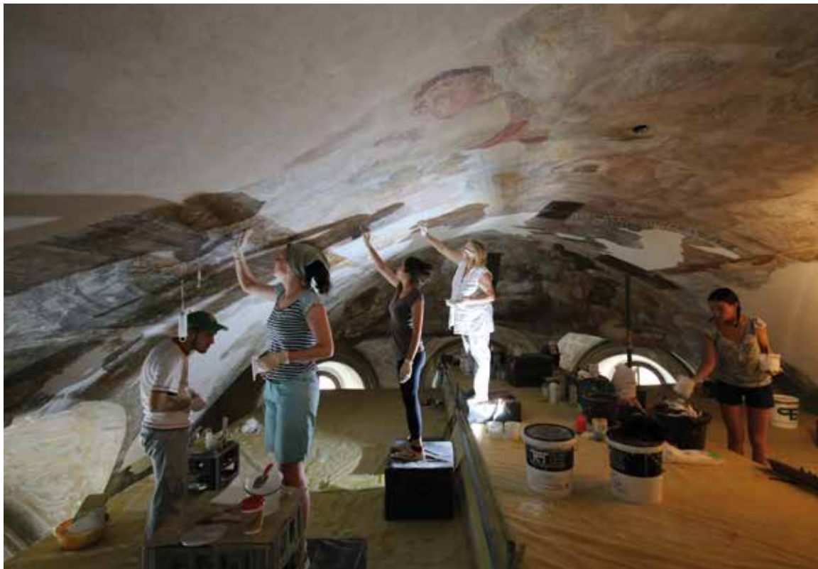
Prezbiterium sklepienie prace konserwatorskie przy freskach F. Ecksteina 2016 r.
