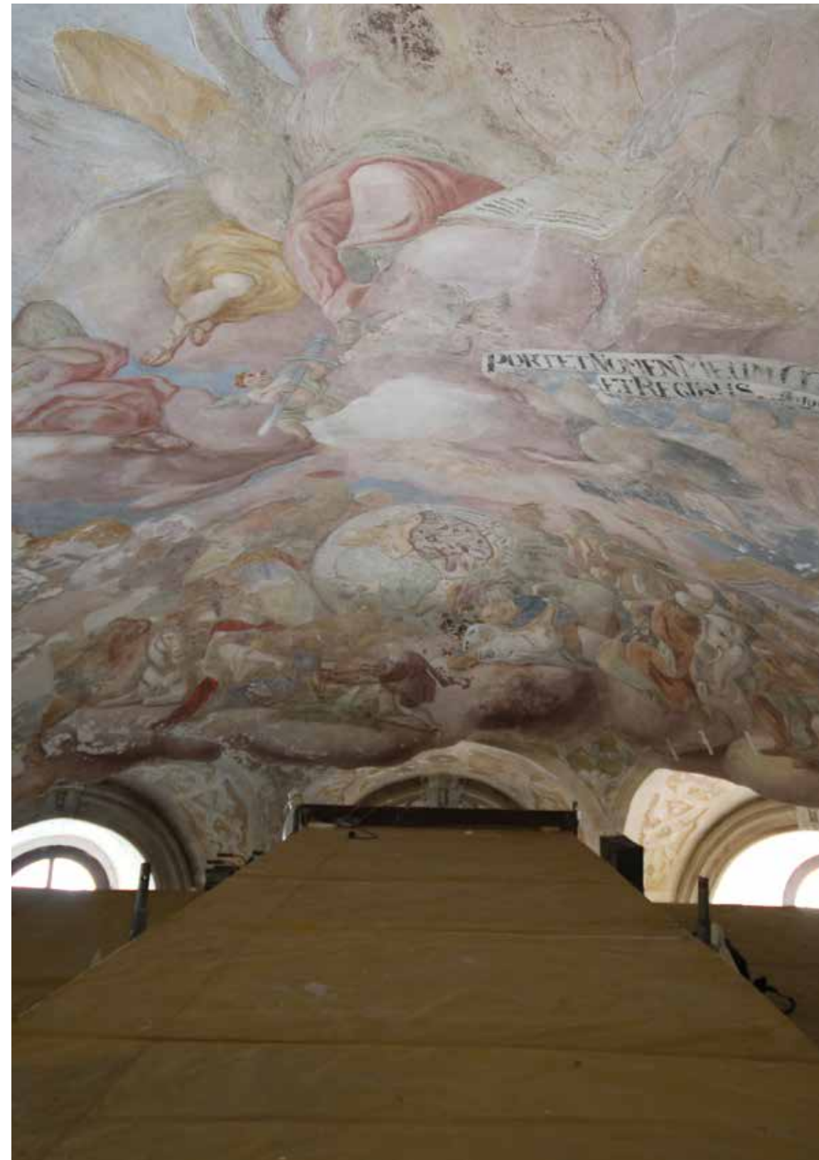
Widok na sklepienie prezbiterium po zakończeniu konserwacji technicznej malowideł 2017 r.
