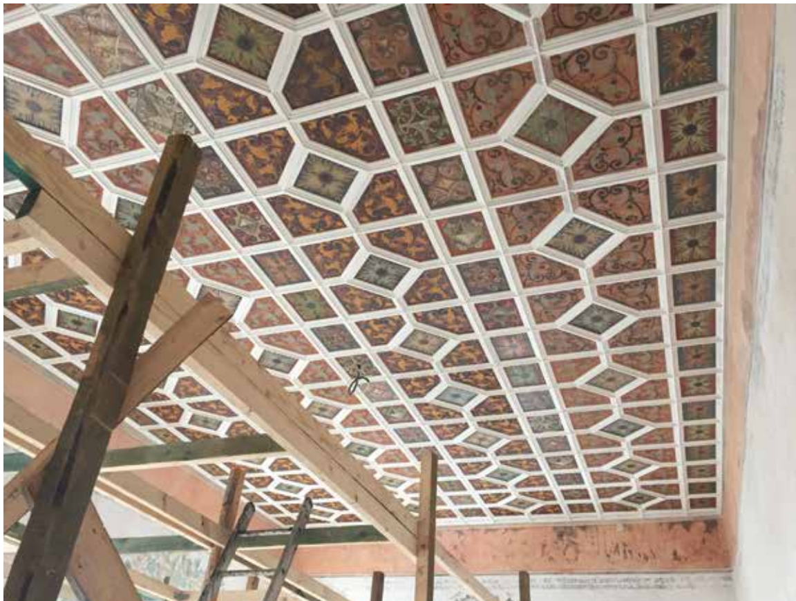
Sala nr II. Rekonstrukcja stropu zrealizowana wg projektu konserwatorskiego.
