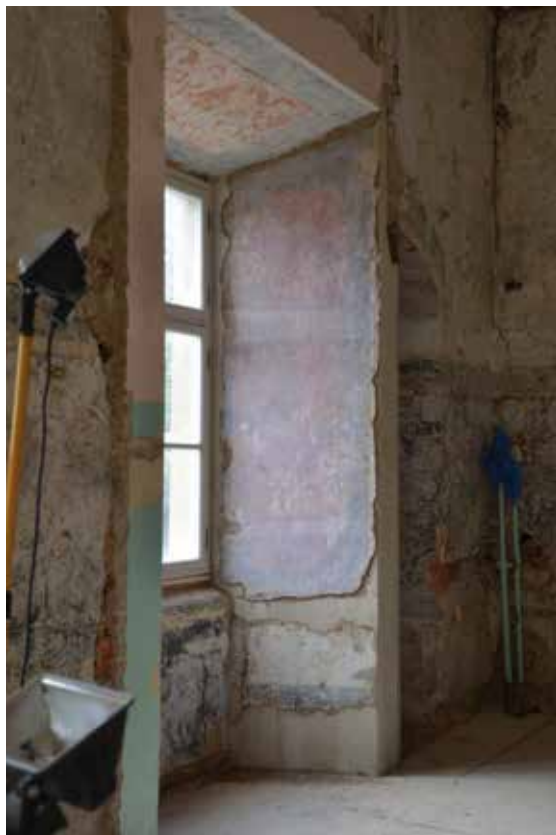
Ponownie osadzone malowidło z dekoracją barokową, na glifie okiennym w sali nr I.
