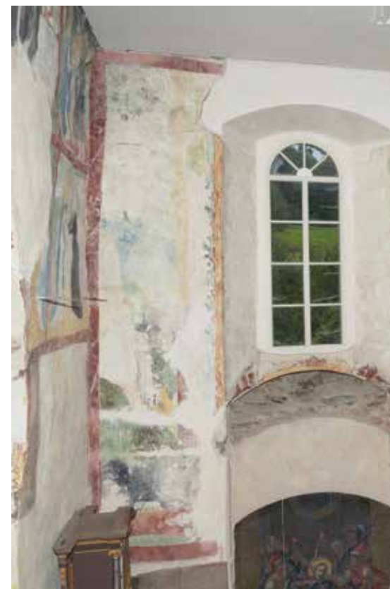
FOT. 4 Nawa, ściana południowa.
