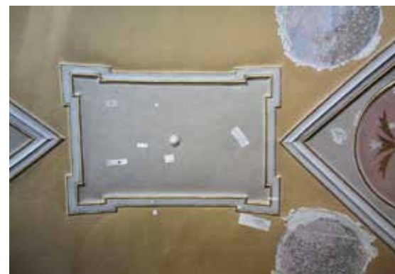
Kaplica pw. św. Barbary, widoczne odkrywki fresku z 1700 r. oraz sondy stratygraficzne, sklepienie.
