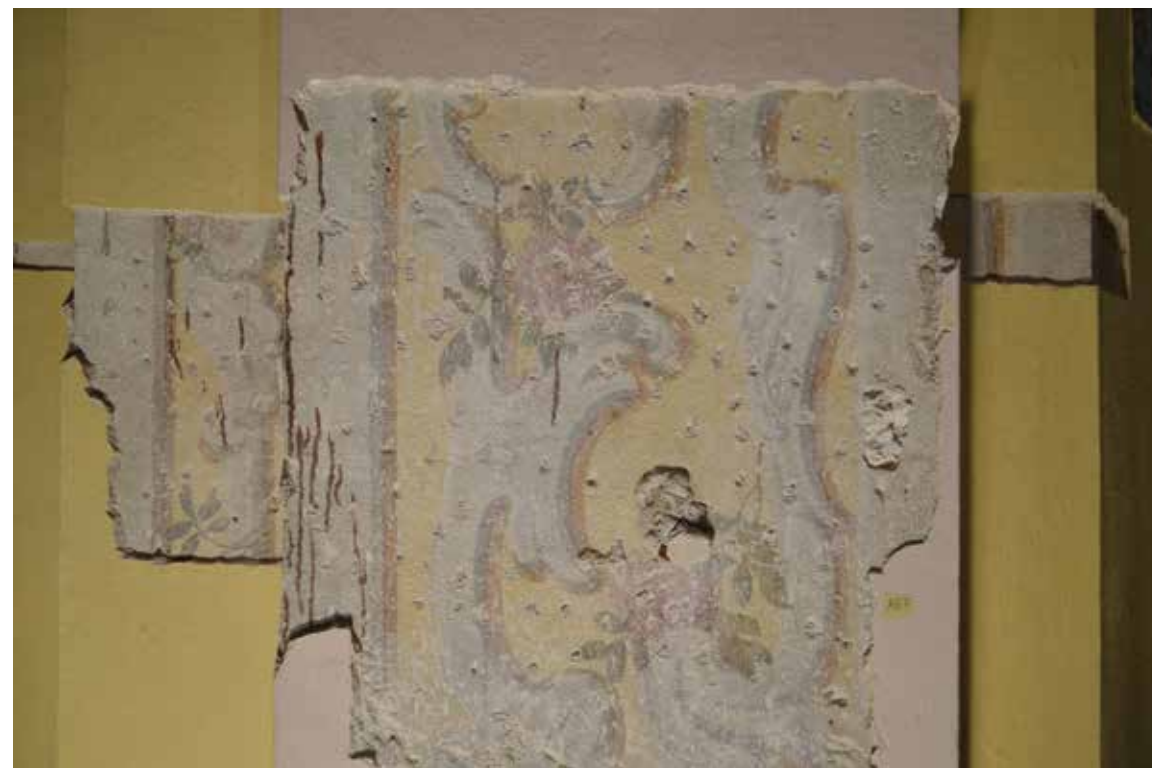
Kaplica pw. św. Antoniego, widoczna odkrywka malowidła z 1765 r., ściana wschodnia.
