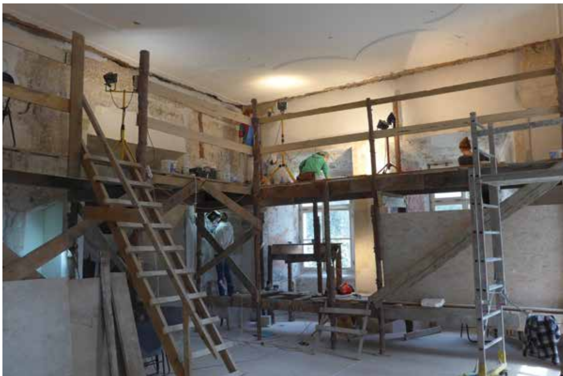
Prace konserwatorskie we wschodniej części sali nr II.
