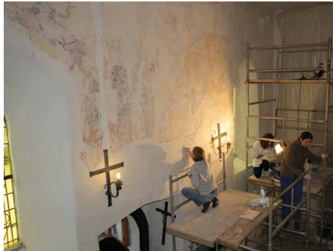
Odsłanianie malowideł na północnej ścianie nawy. Czerwiec 2014 r.
