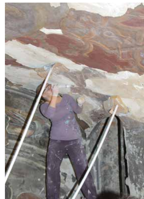
Prostowanie i podklejanie zdeformowanych i odspojonych fragmentów malowidła wraz z zaprawą na emporze północnej 2014 r.
