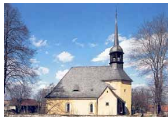
Widok prezbiterium kościoła pw. św. Barbary w Małej Kamienicy w trakcie prac odkrywkowo-badawczych.
