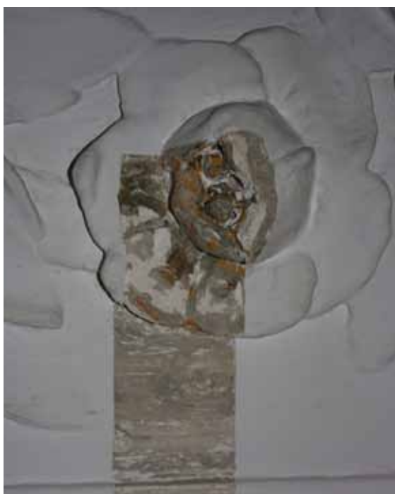
Odkrywka ukazująca pierwotną kolorystykę holu na parterze.
