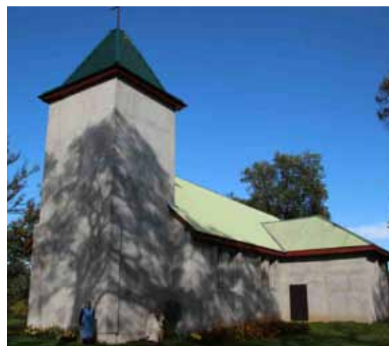
Nowy Kościół w Starkowie, bryła zewnętrzna i wewnątrz wymagające aranżacji.
